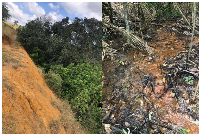
Figura 3 – Erosão e assoreamento da nascente N4 (fonte: O Autor, 2023).
